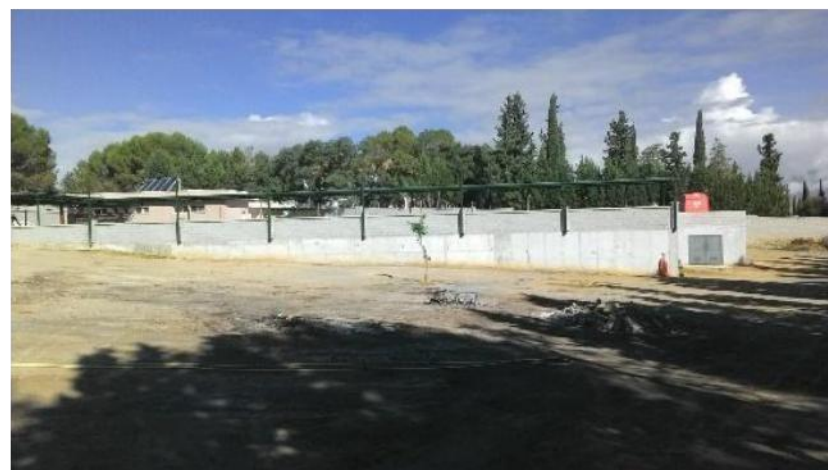
Entorno "Casa del Ingeniero"
